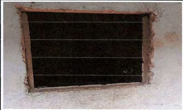
Foto 2: avance mantenimiento de ventanas para la escuela.
