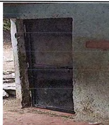
Foto 4: avance mantenimiento de puertas para la escuela.
