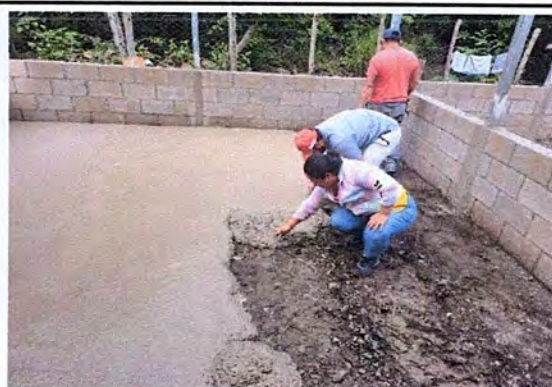
Foto 2: avance del mejoramiento de la loza de piso torta del mejoramiento tipo pórtico.
