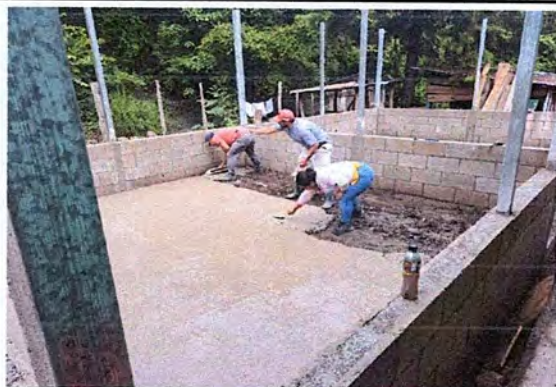
Foto 1: avance del mejoramiento de la loza de piso torta del mejoramiento tipo pórtico.
