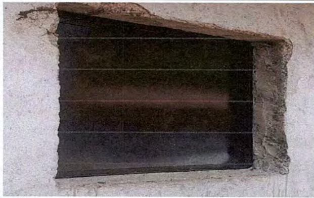
Foto 1: avance mantenimiento de ventanas para la escuela.
