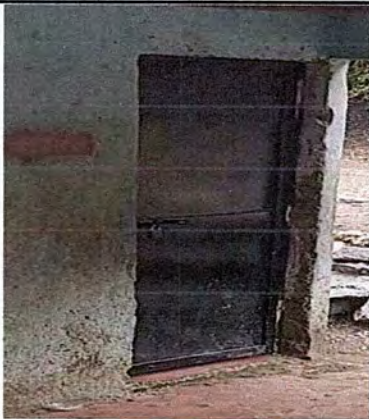
Foto 3: avance mantenimiento de puertas para la escuela.
