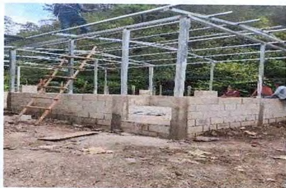
Foto 3: entechado para mejoramiento tipo pórtico.
